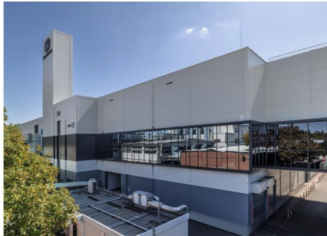
Das neue Gebäude für die Lackieranlage: Im Turm sind die 35 m hohen Abluftleitungen der Anlage installiert.
